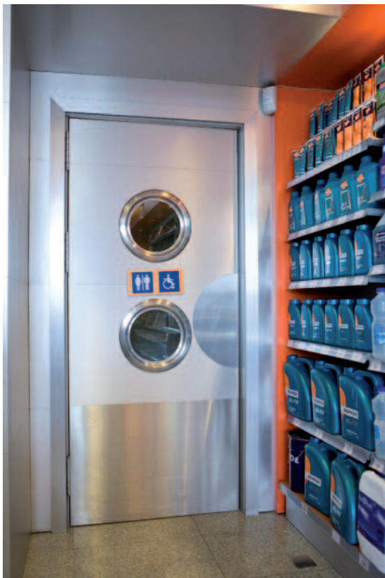
Ejemplo de puerta accesible en una estación de servicio
